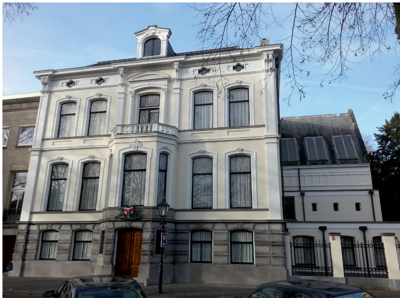
Het bisschopshuis aan Maliebaan 40, Utrecht
